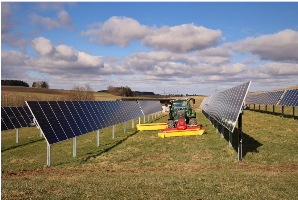
Abbildung 5: Beispiel einer single-axis Agri-PV Tracker-Anlage
