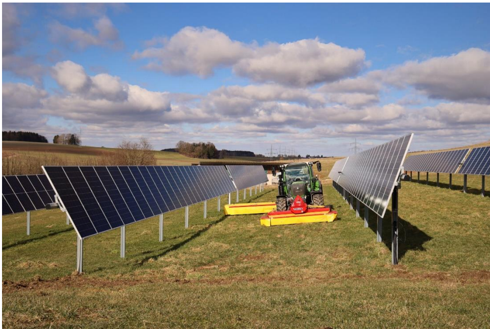
Abbildung 5: Beispiel einer single-axis Agri-PV Tracker-Anlage
