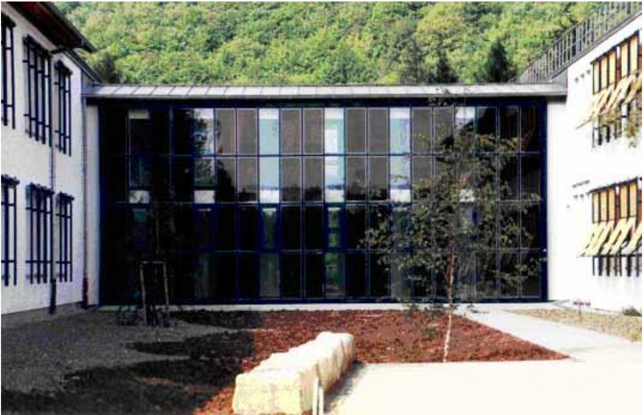
Abbildung 6-3: Solarfassade am Umwelt-Campus Birkenfeld
