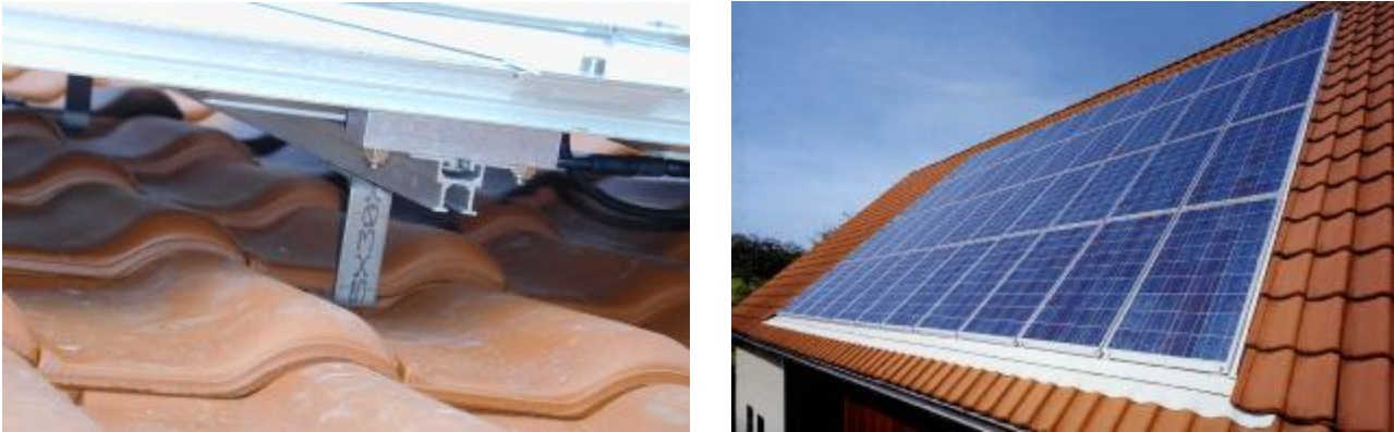
Abbildung 6-2: Auf-Dach-Montage (links) und In-Dach-Montage (rechts)
