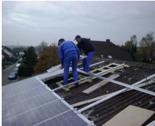
Abbildung 6-1: Montage einer Photovoltaikanlage
