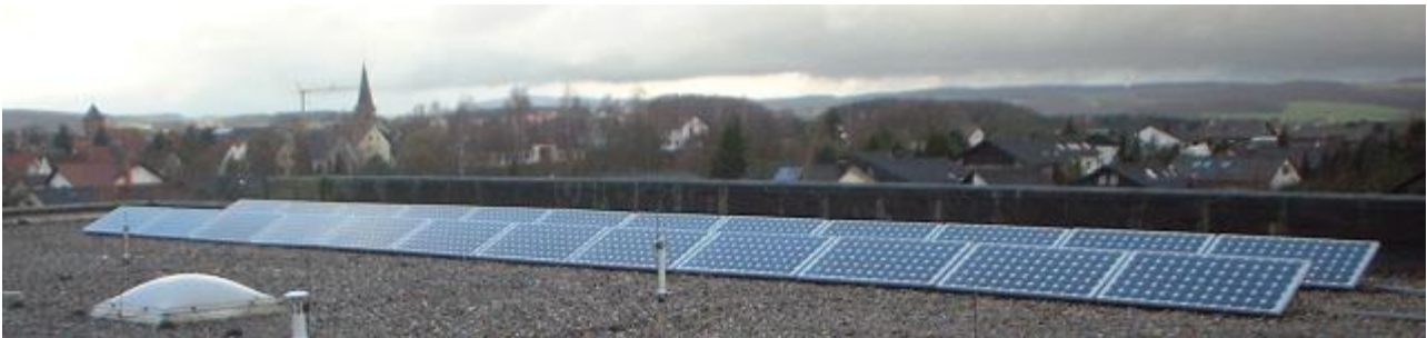
Abbildung 6-5: Flachdachmontage von Photovoltaikmodulen auf der Regionalschule Weilerbach
